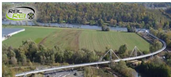
Les Curvoduc™ permettent également des tracés avec des courbes très serrées comme ce transporteur qui permet d'alimenter une centrale thermique en charbon à 600 t/h depuis les péniches venant de la Moselle. Grâce aux courbes de rayons de 250 et 300 m, le tracé en S a permis la réalisation d'un convoyeur à la place de 3 transporteurs droits. Equipé en bande de 1 200 mm, ce Curvoduc™ de plus d'1 km traverse un canal et un parc à cendres.
